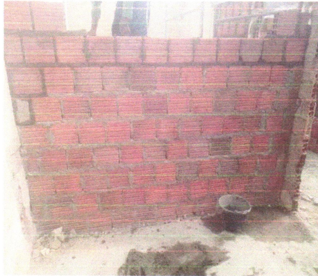
Foto 11 – ALVENARIA DE VEDAÇÃO DE BLOCOS CERÂMICOS FURADOS NA HORIZONTAL DE 9X19X29 CM (ESPESSURA 9 CM) E ARGAMASSA DE ASSENTAMENTO COM PREPARO EM BETONEIRA. AF_12/2021
