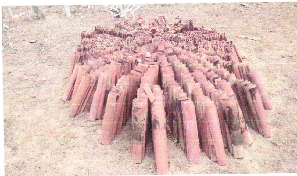
FOTO 09 – REMOÇÃO DE TELHAMENTO COM TELHAS CERÂMICAS
