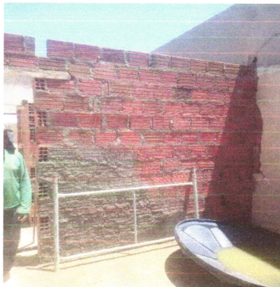
Foto 12 - CHAPISCO APLICADO EM ALVENARIA (COM PRESENÇA DE VÃOS) E ESTRUTURAS DE CONCRETO DE FACHADA, COM EQUIPAMENTO DE PROJEÇÃO. ARGAMASSA TRAÇO 1:3 COM PREPARO EM BETONEIRA 400 L. AF_06/2014
