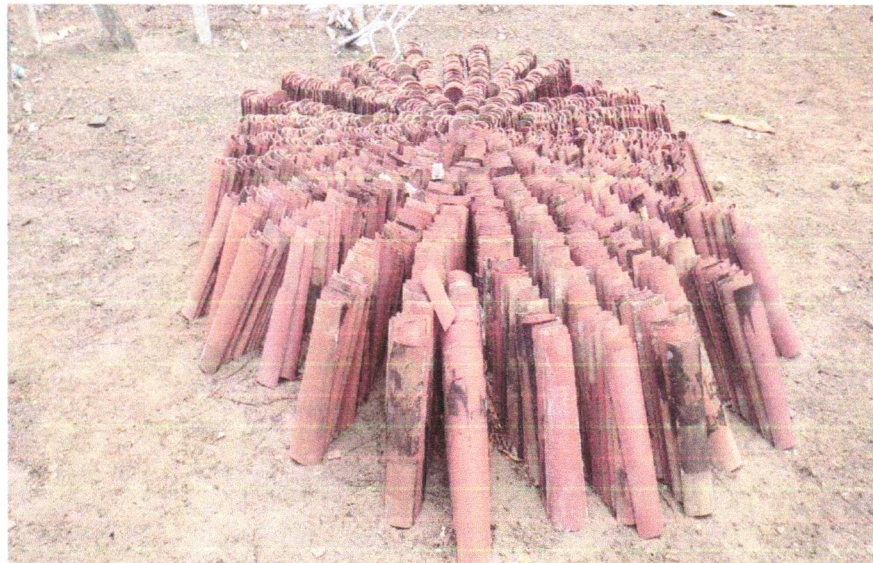
FOTO 04 - REMOÇÃO DE TELHAS, DE FIBROCIMENTO, METÁLICA E CERÂMICA, DE FORMA MANUAL, SEM REAPROVEITAMENTO. AF_12/2017
